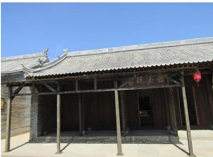
図 12. 新しく葺き替えられた瓦屋根
